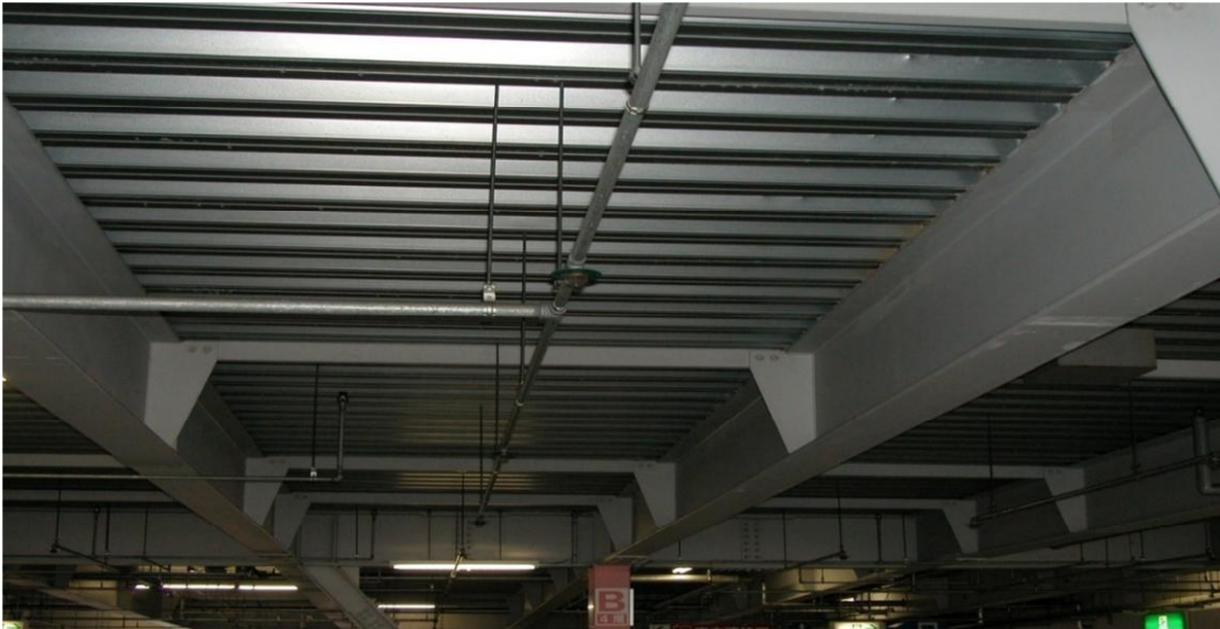
شکل (39): مهار جانبی بال پایینی تیرهای مرکب عرشه فولادی
